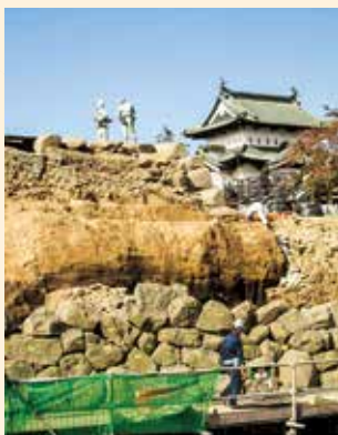
石垣解体 (平成29年10月20日)
