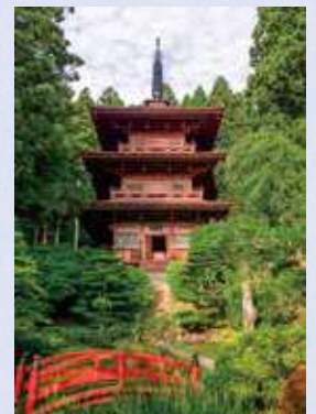
法光寺承陽塔
